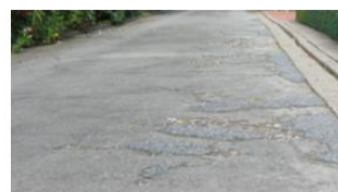
Oberflächenschäden
